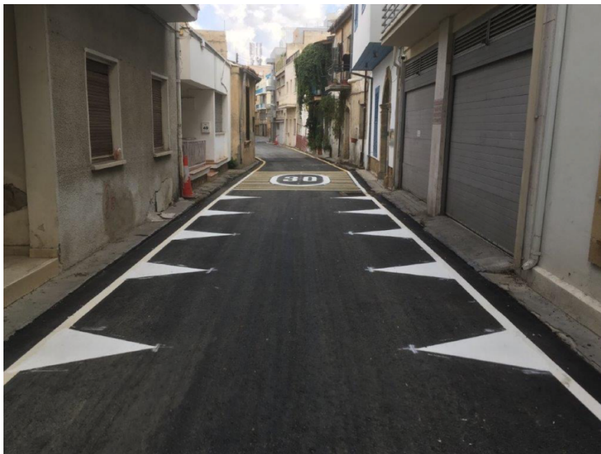
Εικόνα 61: Διαμόρφωση οδού ήπιας κυκλοφορίας με συνύπαρξη πεζού και οχημάτων στο επίπεδο του οδοστρώματος
