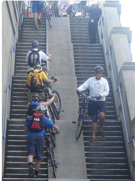
Εικόνα 33. Ράμπα για τη μετακίνηση ποδηλάτων σε διαφορετικά επίπεδα.
