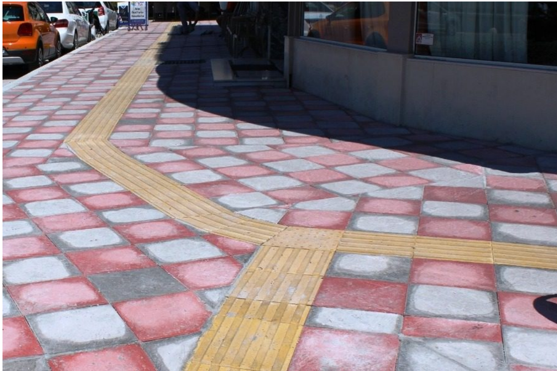
Εικόνα 35: Σταθερό, συνεχές και επιμελές αρμολόγημα (πηγή: https://www.stonisi.gr/post/3211/oloklhrwthhkan-oi-ergasies-sto-telwneio-mylilnhns-pics )
