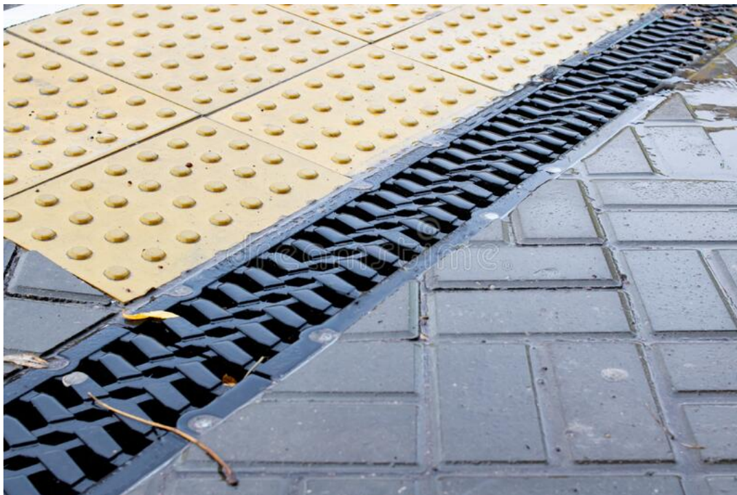
Εικόνα 36: Τοποθέτηση σχαρών στο πεζοδρόμιο (πηγή: https://es.dreamstime.com/ )
